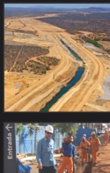
gerenciamento e supervisão
