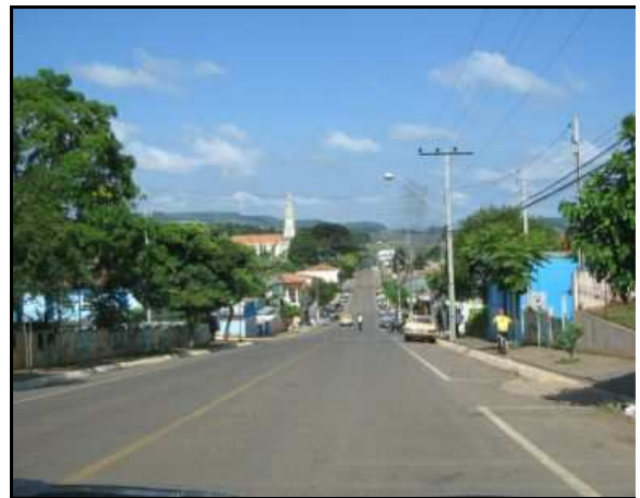
Figura 2 - Rodovia que atravessa a cidade de Ivaí – PR. Foto: Dias, F. V., 2007
